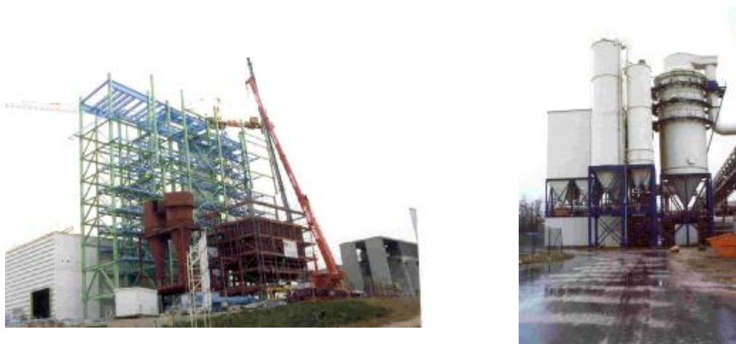
Bild 16: Biomasseverbrennungsanlagen in Wicker und Großräschen im Bau
